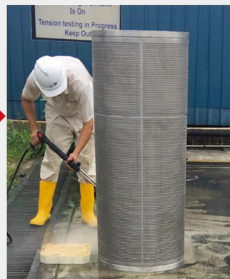
反冲洗失效后人工清洗场景
